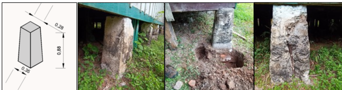
Foto 1. Pedestales de Concreto
