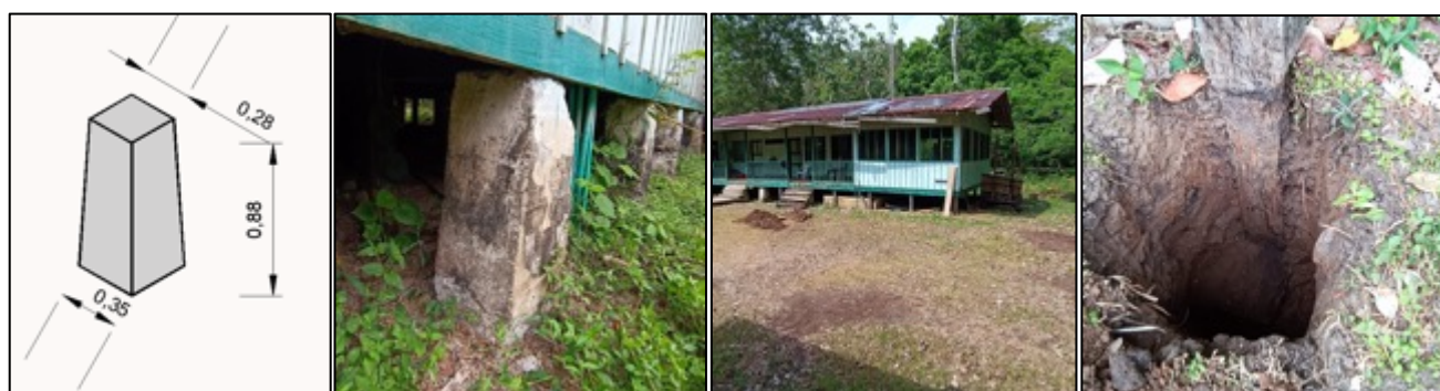
Foto 8. Sistema Mixto de Cimentación Zona 3 – Alojamiento y Salón Comunicaciones
