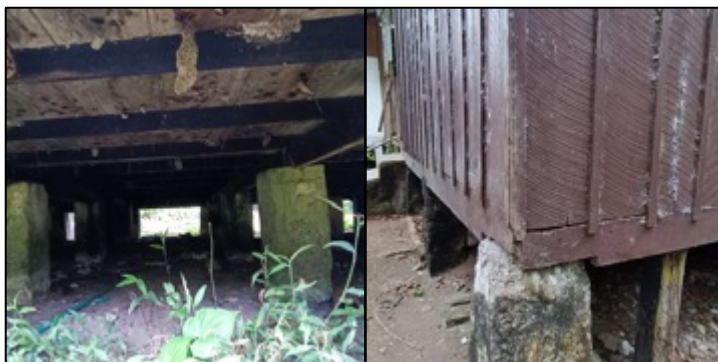
Foto 2. Sistema Mixto de Cimentación que Soporta malla de Vigas y Viguetas
