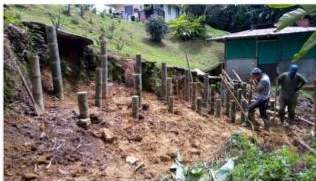
Finca Agroecológica y turística La Arcadia. Sustitución de cerca viva y cerca muerta. Instalación de trinchos (bioingeniería).
