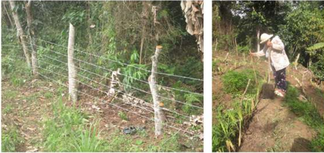
Finca Benedita. Instalación de cerca viva y cerca muerta. Instalación de huerta familiar.
